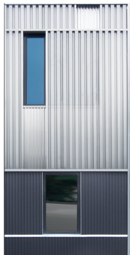
Gare de Viennes Ouest profilé trapézoïdal Aluform 45/150 lustré lisse, perforé
