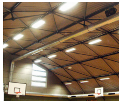
Gymnase Winzerla - Allemagne, Profilé sinusoïdal Aluform 55/177 perforé & bombé avec feutre acoustique
