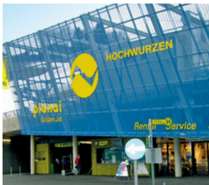
Station de ski Planai - Autriche, profilé sinusoïdal Aluform 55/177 perforé
