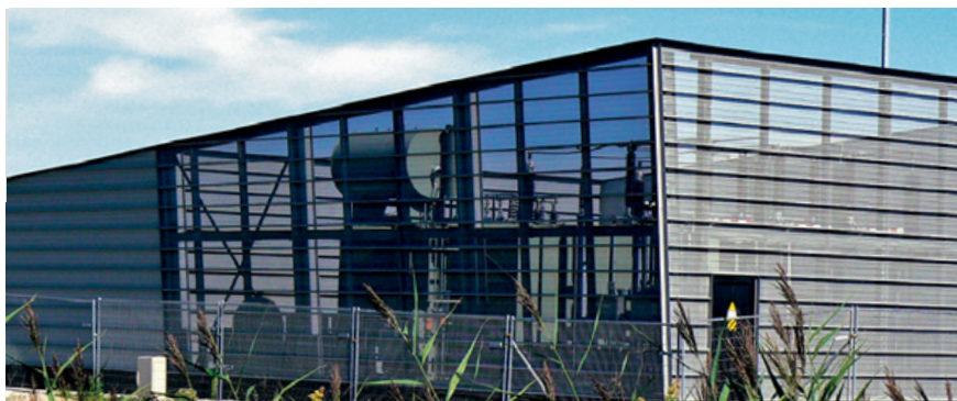
Stockage tampon de gaz naturel Zuiderwending - Hollande, profilé de joint debout Aluform 64/400 perforé
