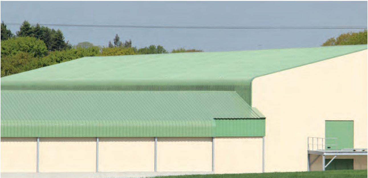
Jl 45-333-1000 Toiture (PML 45.333.1000 CS)
