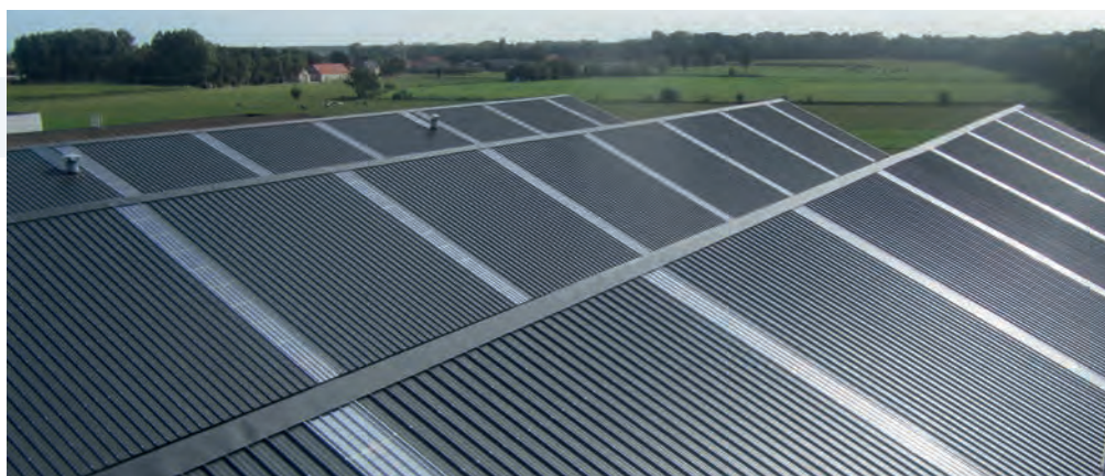
Assemblage du JI 45-333-1000 Toiture (PML 45.333.1000 CS) avec des translucides.
