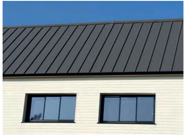
Jl 37-250-1000 (PML 37.250.1000 CS) pour une application tertiaire.
