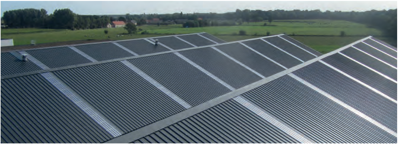
Réalisation industrielle avec JI 45-333-1000 Toiture et plaques translucides.
