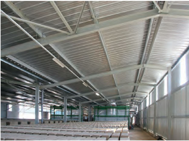
Jl 45-333-1000 Toiture (PML 45.333.1000 CS)
