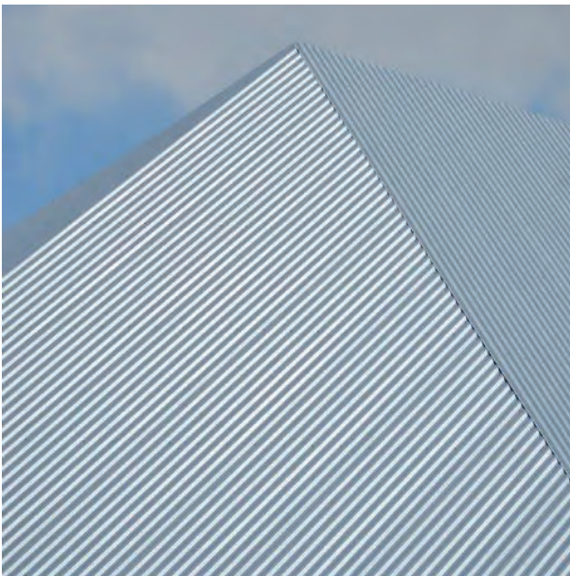
Jl 25-125-1000 Toiture (PML 25.125.1000 CS)
