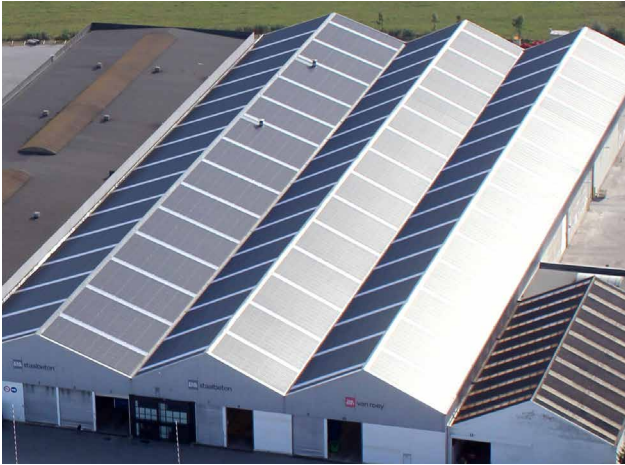
Batiments industriels avec solutions éclairantes.
