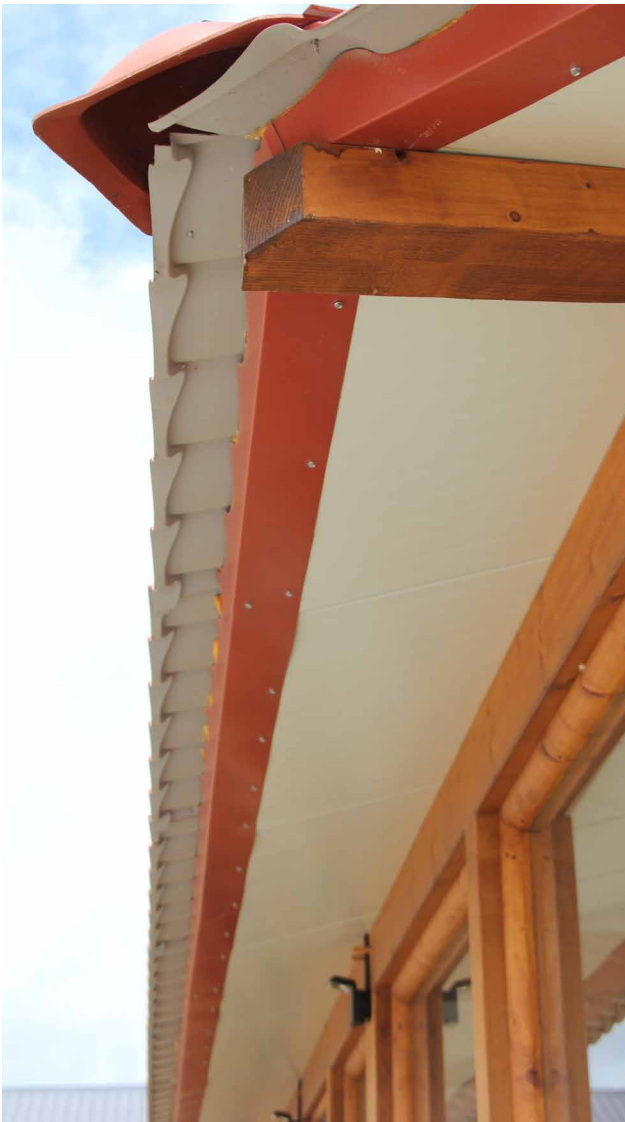
Closoirs pour panneaux tuiles afin de traiter la problématique de l'étanchéité.
