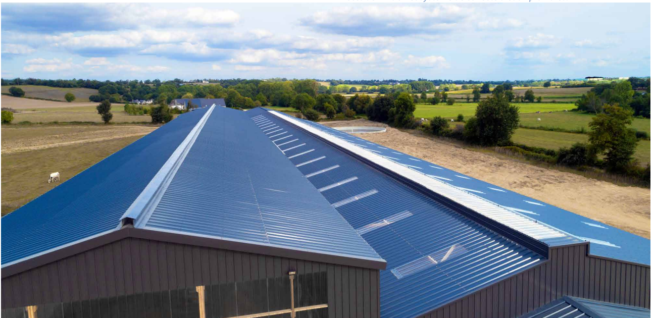
Faitière double pour réalisation agricole.
