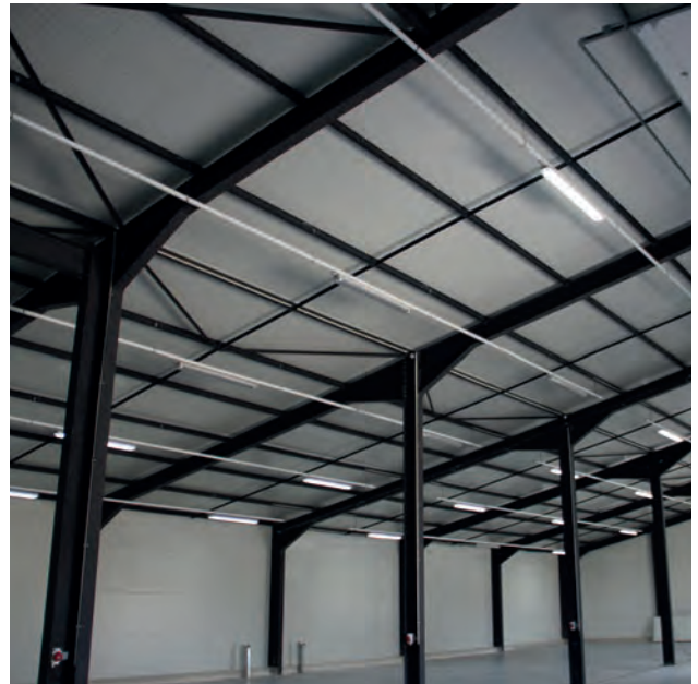
Batiment de stockage viticole réalisé en JI Roof PIR (Beaune - 21)
