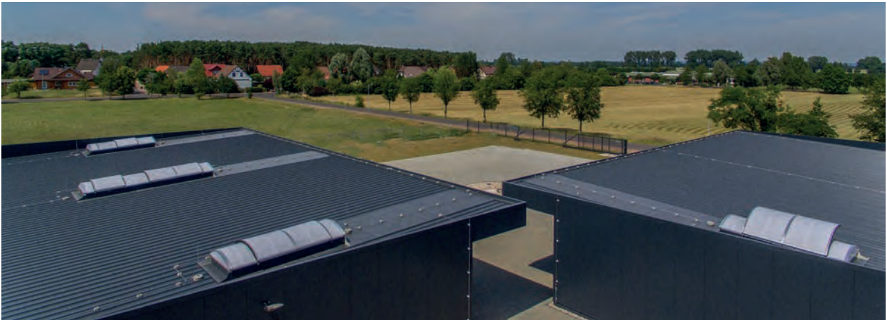
Plusieurs bâtiments réalisés avec notre JI Roof PIR - 120 mm.
