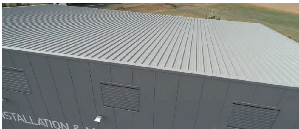
Jl Roof PIR pour toiture d'un bâtiment industriel en Vendée.
