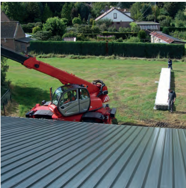
Mise en oeuvre avec Jl Eco PIR.
