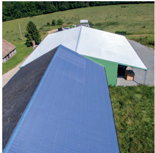
Rénovation agricole avec notre JI Roof PIR.
