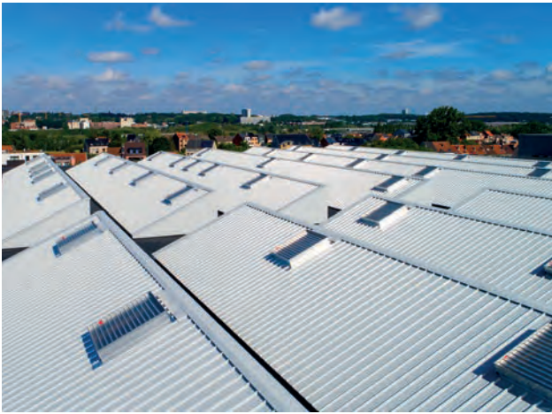
Plusieurs milliers de m 2 de toiture industrielle.
