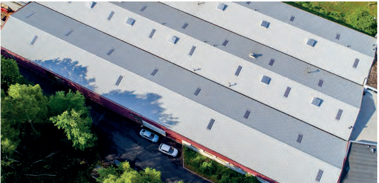
Site industriel de 4000m 2 réalisé en JI Vulcasteel Roof (Vosges - 88).
