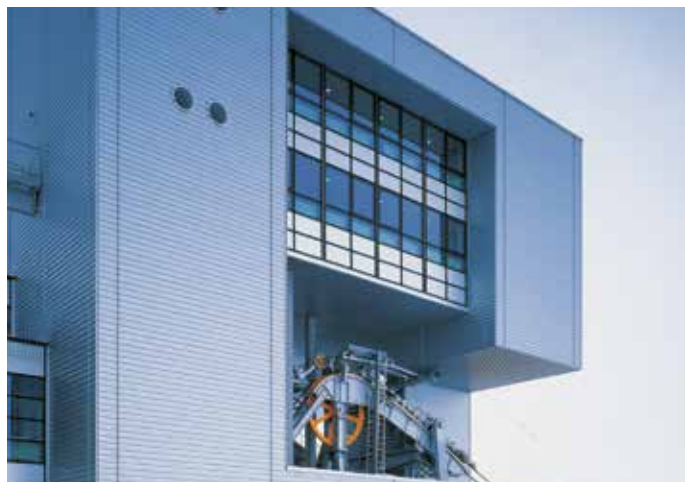
Station amont du Col du Pillon (CH) Architecte: Mario Botta
